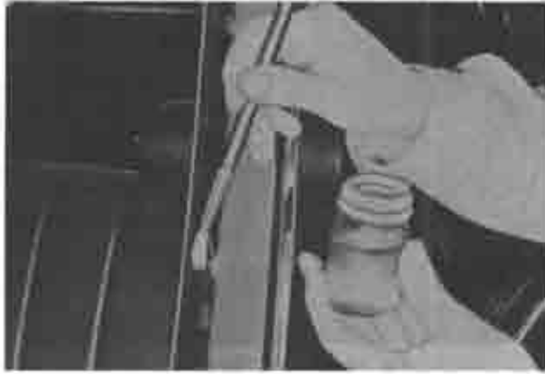
Fig. 14-27 Applying primer
