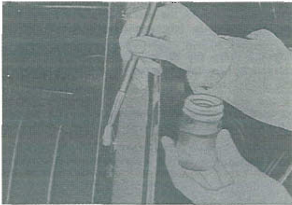
Fig. 14-28 Applying of primer
